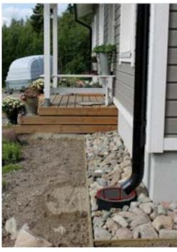
Der Fallrohr-Bodenfilter eignet sich auch hervorragend als offener Filtertopf. Der Filterkorb kann optional mit Kies gefüllt werden, was eine zusätzliche Reinigung des Regenwassers bewirkt.
